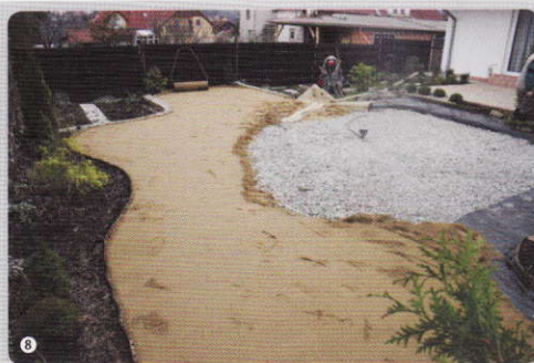
Štěrk byl zhutněn a na řadu přichází prosetý říční písek
