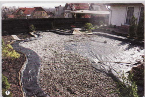
Na dno přišla plachta, drenáž a štěrk
