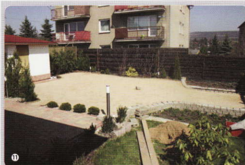
Elektrikáři instalovali lampy... a čeká nás dalších 14 dní válcování
